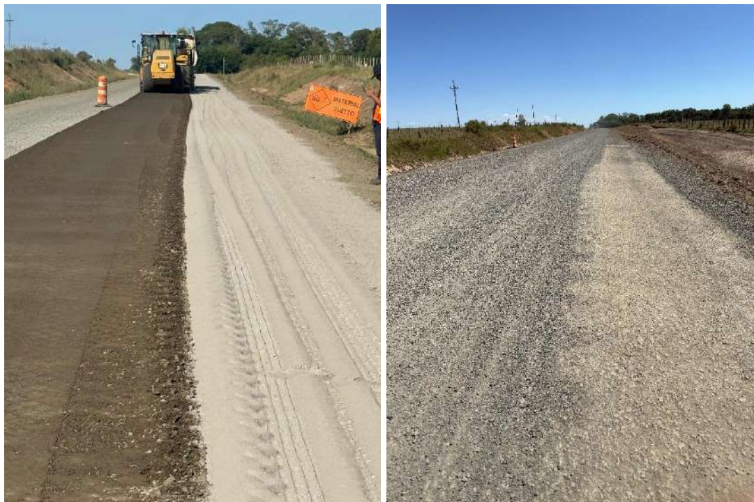
Imagen N°6 y 7: Estabilizado de base con cemento.
