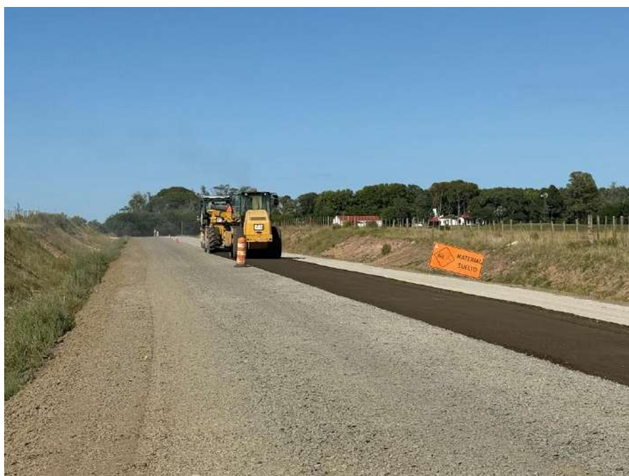
Imagen N°5: Estabilizado de base con cemento.
